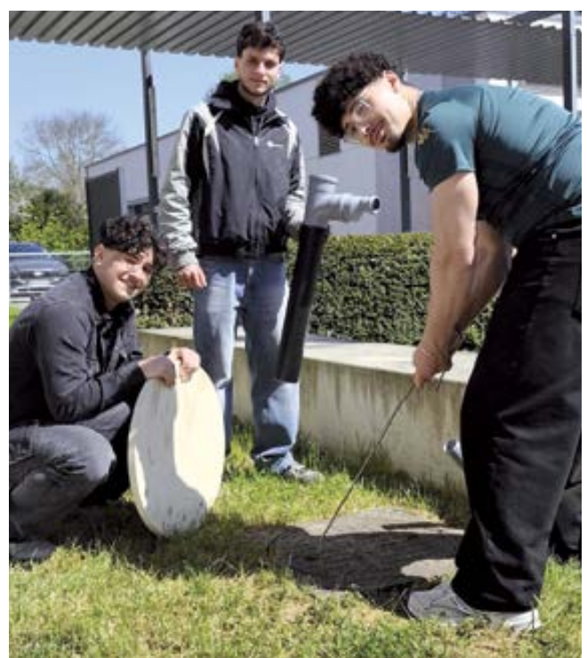
■ Omed, Maximilian und Souhaib bei der Arbeit an der Abwasserlösung
