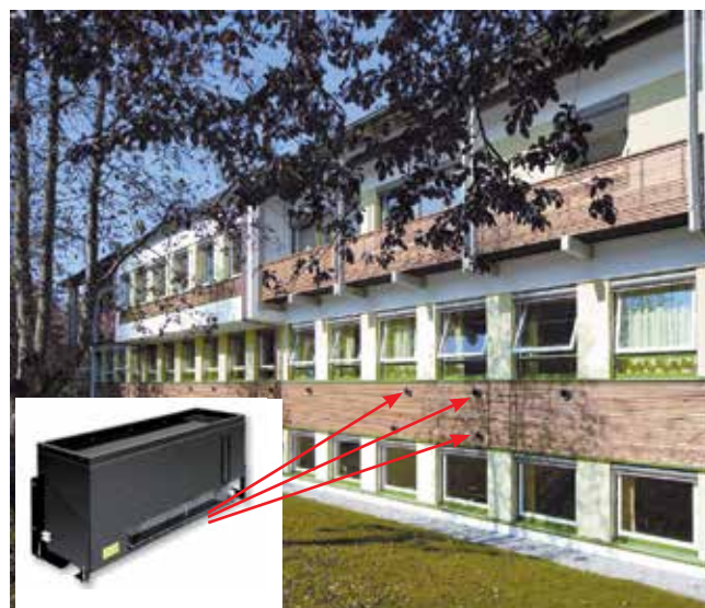
■ Nachrüstung an einer Schule am Chiemsee von außen. Unten li. ein Mustergerät vergleichbar mit einem Elektrospeichergerät.
