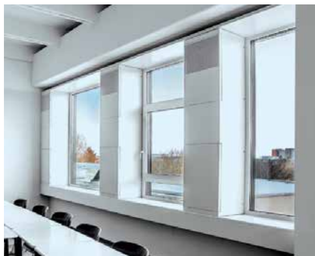
■ Trox Nachrüstungen zwischen den Fenstern im Innenraum
