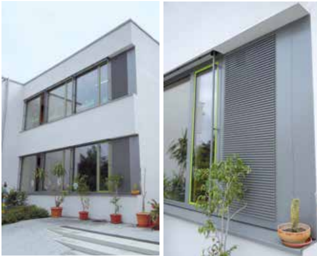
■ Nachrüstungen rechts neben den Fenstern von außen.
