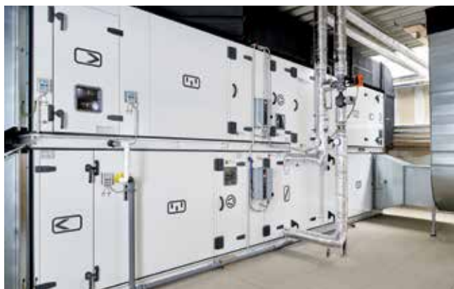
■ Abbildung links: zentrale Lüftungsanlage (Bild: Trox), rechts: dezentrale Lüftungsanlage (Bild: Wolf)
