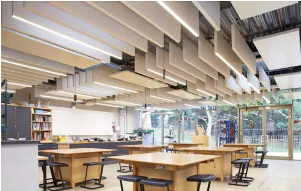
■ Staub kann sich entzünden. Deswegen sind in Werkräumen Leuchten angebracht, die gegen Entzündung und Entflammung geschützt sind. (Foto: licht.de/Ridi)
